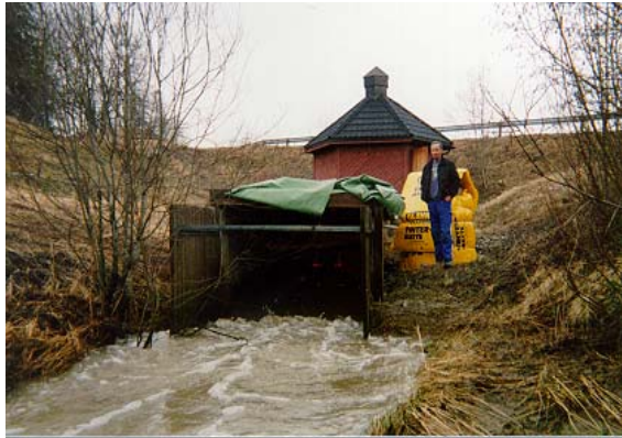
Figur 2. Mørdrebekken målerenne, Crump-overløp. Foto: Marianne Bechmann
